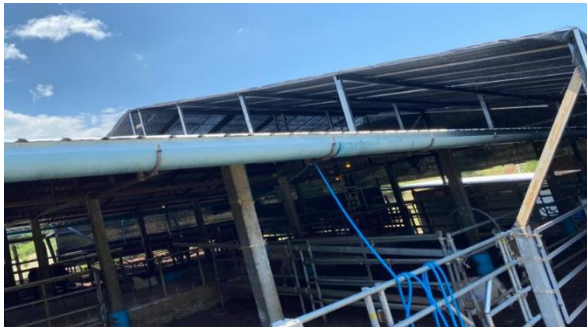
ภาพที่ 2 โรงเรือนกลุ่มทดลอง: ก. โรงเรือนที่คลุมหลังคาด้วยแสลง; ข. โรงเรือนที่ติดตั้งเครื่องพ่นไอน้ำแบบละอองฝอยและพัดลม
