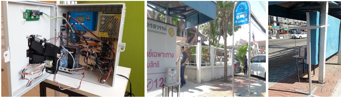
ภาพที่ 6 แสดงการติดตั้งเข้ากับตู้
