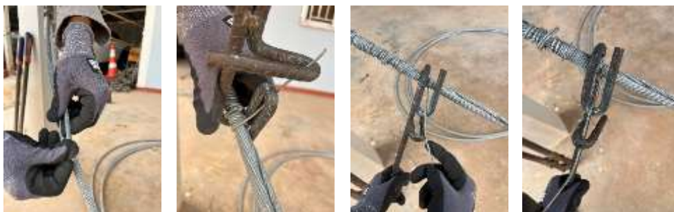
ภาพที่ 9 แสดงวิธีการใช้งานเครื่องมือพันลวดเหล็กสายยึดโยงเสาไฟฟ้า
