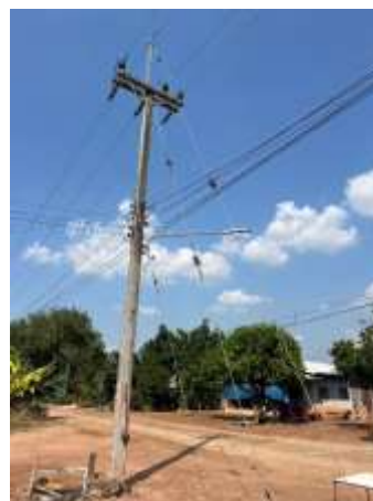
ภาพที่ 13 แสดงการติดตั้งสายยึดโยงเสาไฟฟ้าที่ใช้งานจริง
