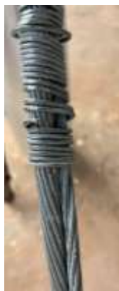
ภาพที่ 12 แสดงการพันลวดเหล็กด้วยเครื่องมือพันลวดเหล็กสายยึดโยงเสาไฟฟ้าที่ใช้งานจริง
