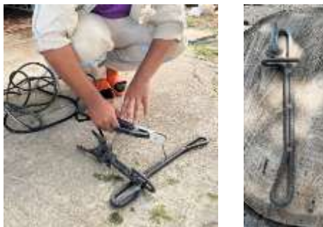
ภาพที่ 7 แสดงเครื่องมือพันลวดเหล็กสายยึดโยงเสาไฟฟ้า
