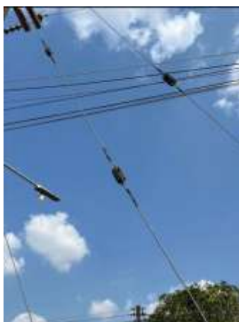
ภาพที่ 13 แสดงการติดตั้งสายยึดโยงเสาไฟฟ้าที่ใช้งานจริง
