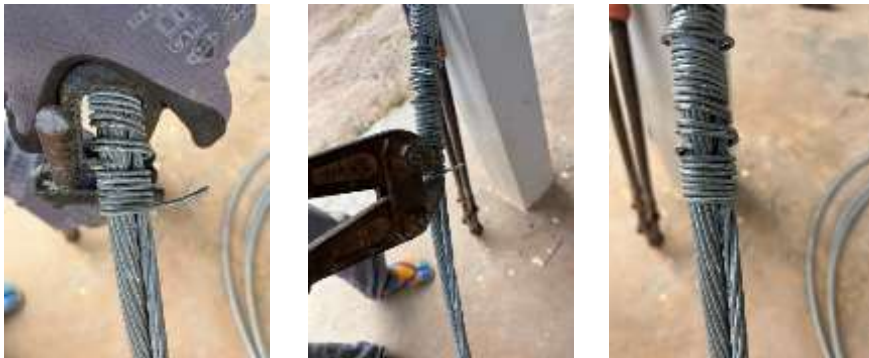
ภาพที่ 10 แสดงการพันลวดเหล็กด้วยเครื่องมือพันลวดเหล็กสายยึดโยงเสาไฟฟ้า
