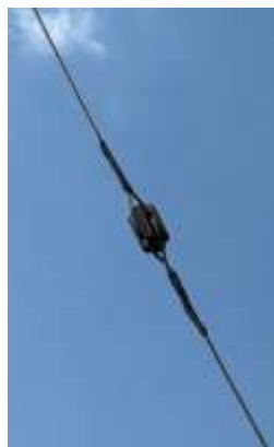
ภาพที่ 12 แสดงการพันลวดเหล็กด้วยเครื่องมือพันลวดเหล็กสายยึดโยงเสาไฟฟ้าที่ใช้งานจริง
