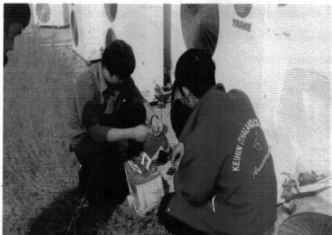
ภาพที่ 21 แสดงขั้นตอนการประกอบชุดผลิตไฟฟ้าจากคอมเพรสเซอร์เครื่องปรับอากาศ
