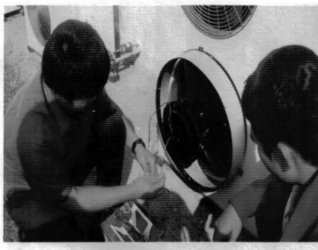
ภาพที่ 20 แสดงขั้นตอนการประกอบชุดผลิตไฟฟ้าจากคอมเพรสเซอร์เครื่องปรับอากาศ
