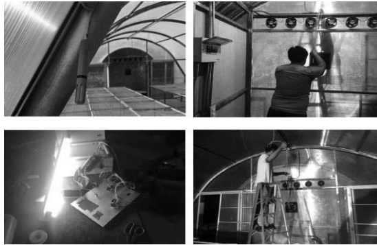
ภาพที่ 12 ดำเนินการติดตั้งเซ็นเซอร์ภายในโรงอบแสงอาทิตย์
