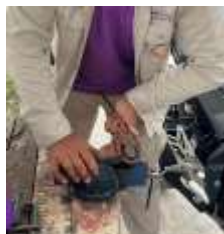
ภาพที่ 6 แสดงการตัดเหล็กขอยตามแบบร่าง
