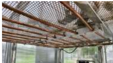
ภาพที่ 2 แสดงโครงสร้างท่อทองแดงและการติดตั้งใต้ถาดตากผลิตภัณฑ์แต่ละชั้น
